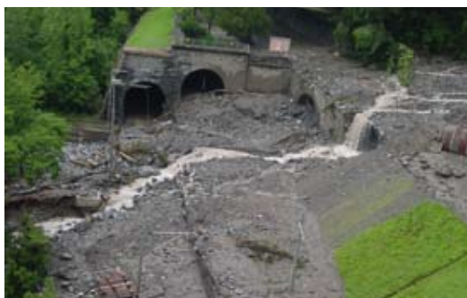
Abbildung 5: Hochwasser August 2005, Dornibach/SZ (Quelle: SBB)
