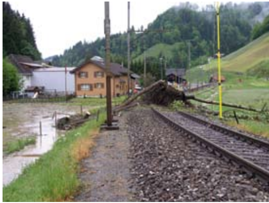
Abbildung 6: Baum auf Fahrbahn, Wiggen (Bild: SBB)
