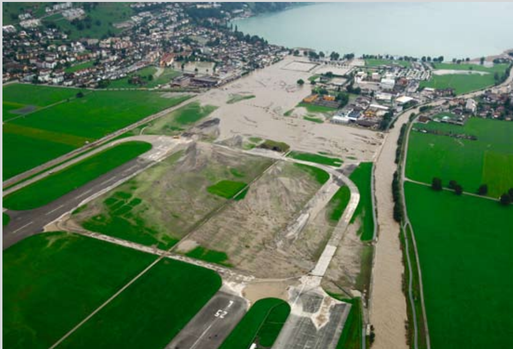
Abbildung 3: Im August 2005 wurde das Hochwasser der Engelberger Aa um das Schadenempfindliche Siedlungsgebiet geleitet. (Quelle: Schweizer Luftwaffe 2005)
