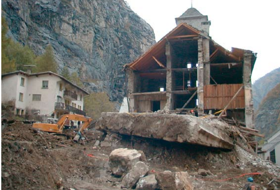
Abbildung 2: Murgang im Herbst 2000 in Gondo, VS, nach heftigen Niederschlägen. (Quelle: Vereinigung Kantonalen Feuerversicherungen, Kommission für Elementarschadenverhütung. VKF, Bern)
